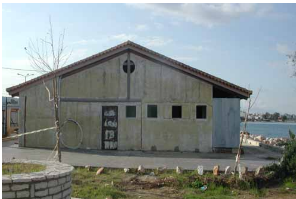
Το κτίριο που κατασκευάζεται, στη θέση του παλιού, το έτη 2004, 2007, 2008, στη ζώνη παραλίας της Κρύας Ιτεών (βόρεια πλευρά –προς Πάτρα), όπως φωτογραφήθηκε τον Οκτώβριο του 2007
