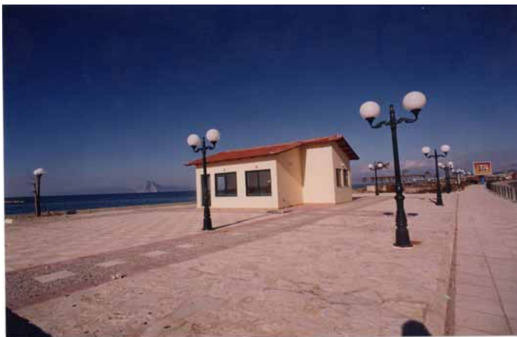
Κτίριο και διαμόρφωση χώρου, όπως παραδόθηκε το τέλος του 2001, στη ζώνη παραλίας της Κρύας Ιτεών(νότια πλευρά-προς Πύργο)
